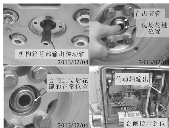
图 4 50231 隔离开关机构拆解示意图
