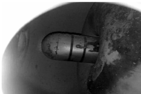
图 3 50231 隔离开关动静触头示意图
